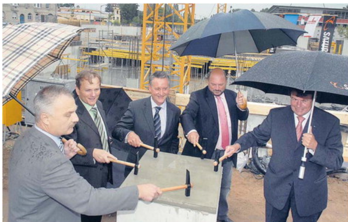
Grundsteinlegung für ein zähes Großprojekt: (von links) Baureferent Joachim Krauße, Wirtschaftsreferent Horst Müller, Oberbürgermeister Thomas Jung sowie die Saturn -Vertreter Volker Mendel und Alfred Ullrich. Foto: Kronau
