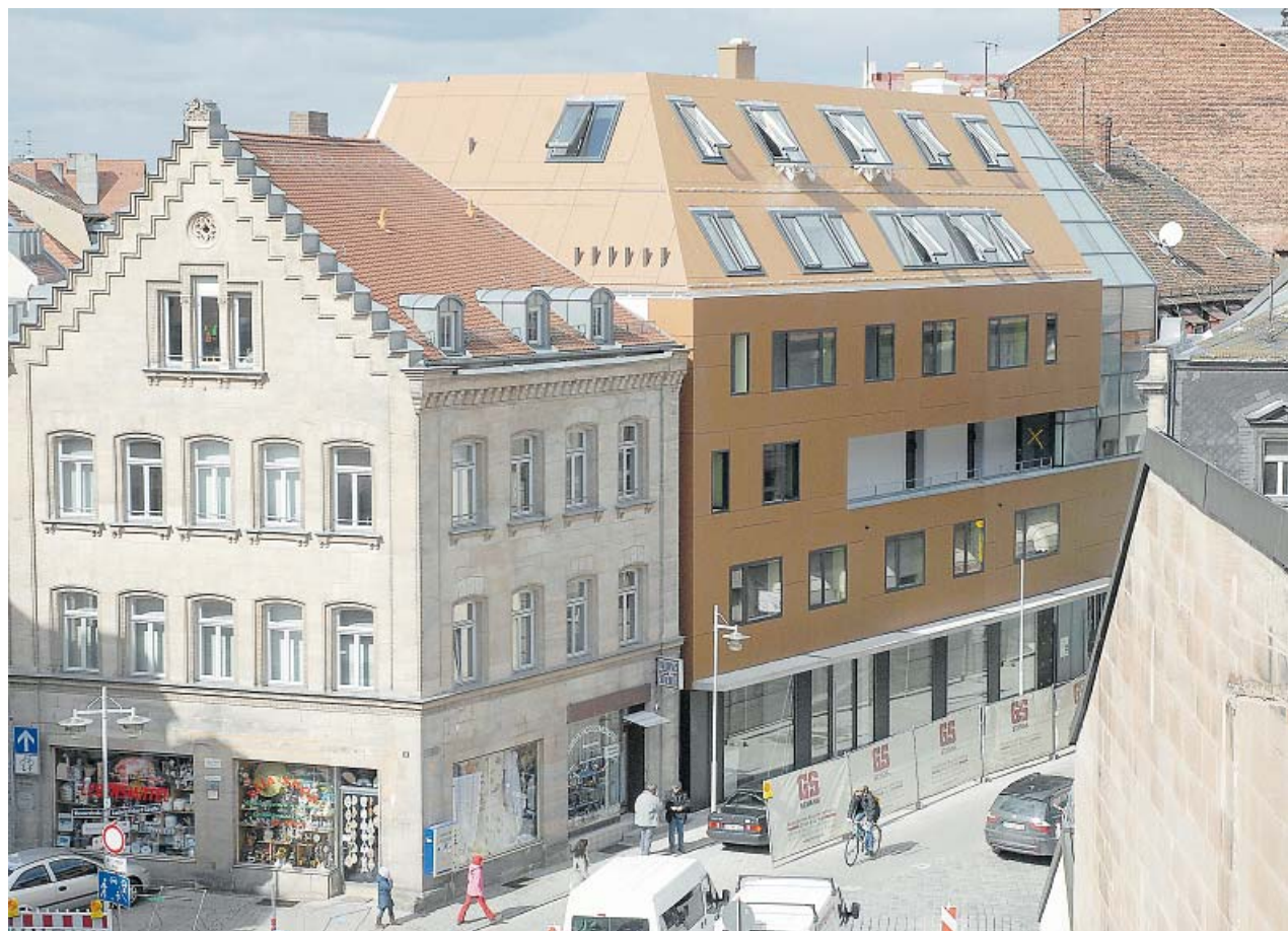
Einen Blickfang bildet der moderne Neubau in der von historischen Bauten geprägten Ludwig-Erhard-Straße. Architekt Peter Dürschinger setzt auf die Spannung der Kontraste. Foto: Thomas Scherer
